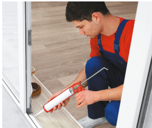
La pose d'un joint d'isolation aux fenêtres, entre le cadre ouvrant et le cadre dormant, est facile et vous permet d'augmenter votre confort acoustique.
