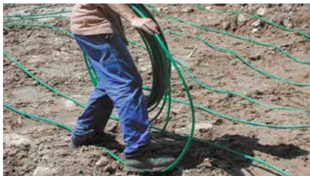
Pose de capteurs horizontaux.
