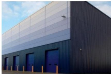
Kingspan EnergiPanel TM suit le même système constructif que des panneaux sandwich avec les ???. Le principe consiste à récupérer la chaleur accumulée dans chacune des rainures.
