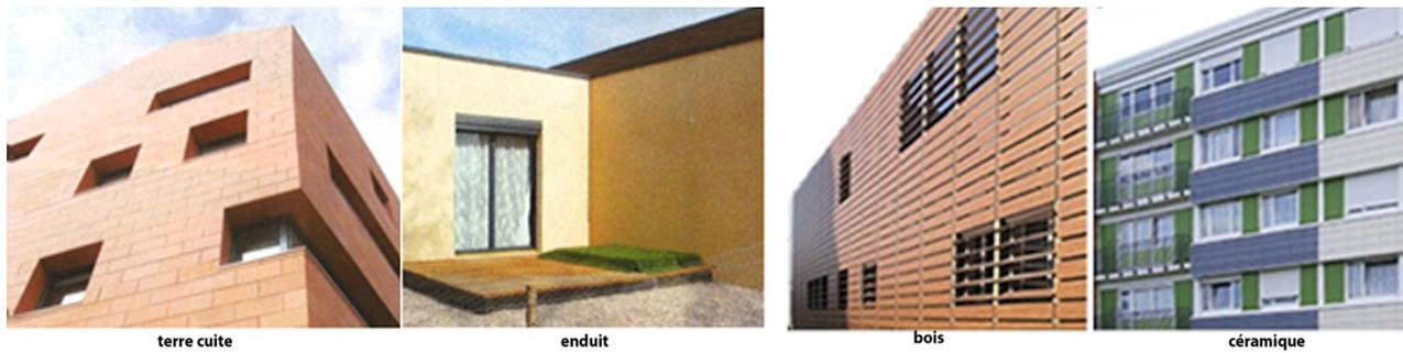
Figure 2 : Types de rendu de façade avec une isolation par l'extérieur
